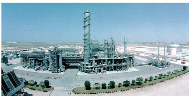
メタノールプラント
